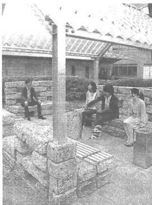
大谷石を再利用した東屋。古い石も多く、つるはして掘り出した跡が残る石も＝宇都宮市で
